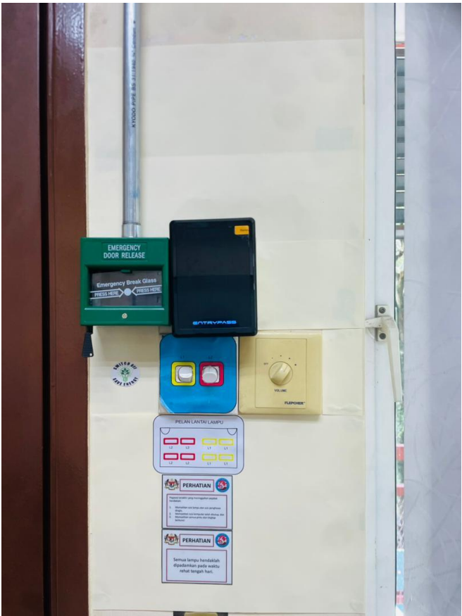
Penambahbaikan: Keadaan dinding telah ditambah baik.
