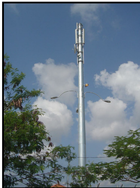
Gambar 5 – Menara telekomunikasi Jenis Multi-fungsi – Lamp pole
